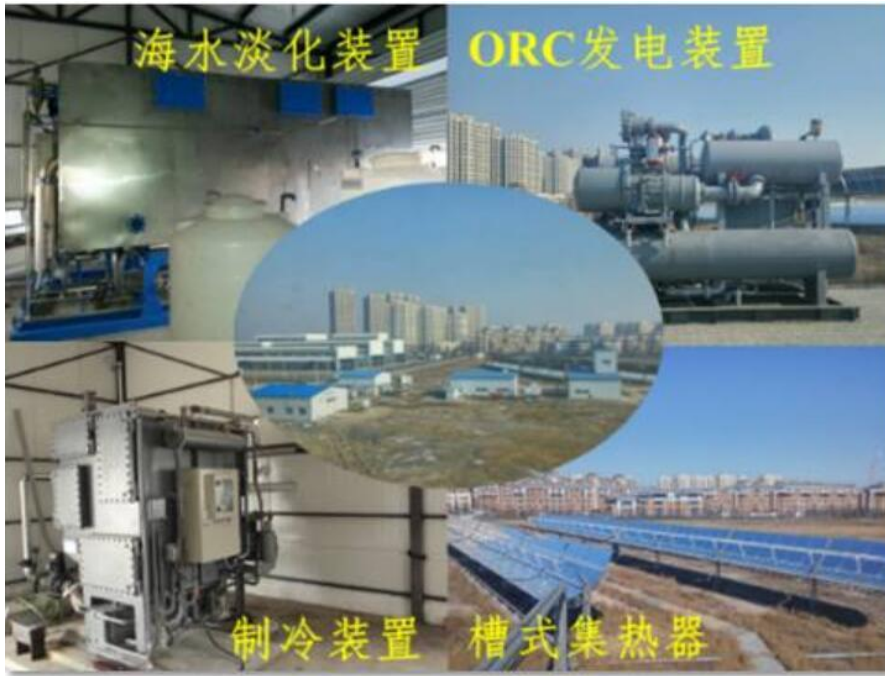
图：耦合技术及中试系统
